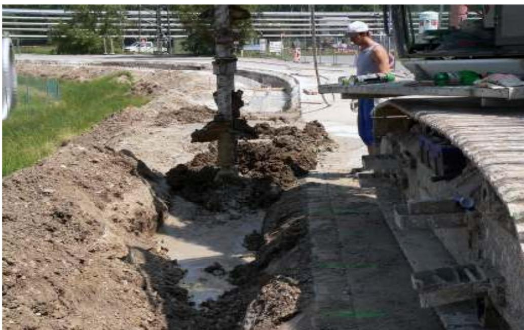
Abbildung 8: Errichtung der Dichtwand (Quelle: WOLF, 2007)
