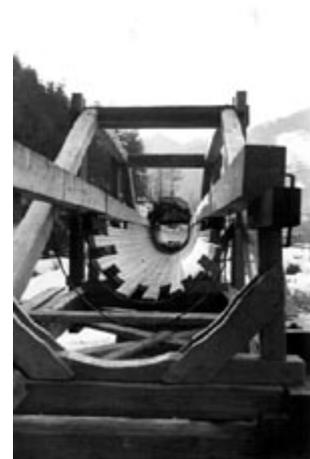
**Abbildung 2: Querschnitt durch den eiförmigen Schwemmkanal**
